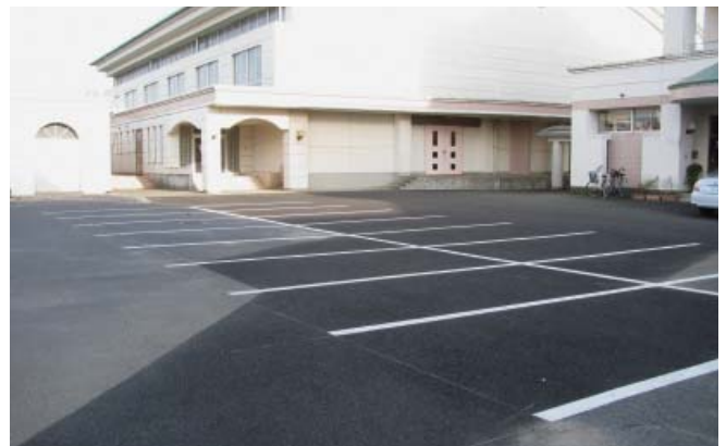
復旧した横瀬小学校体育館・駐車場
