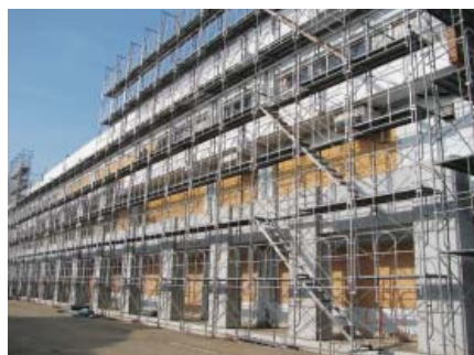
耐震化工事（息栖小学校）
