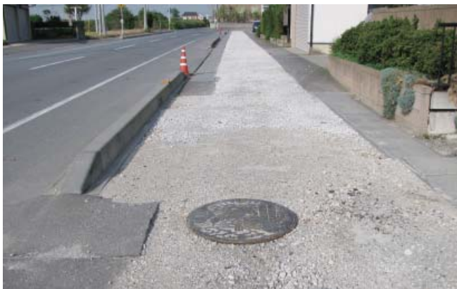
仮復旧した下水道（堀割地区）
