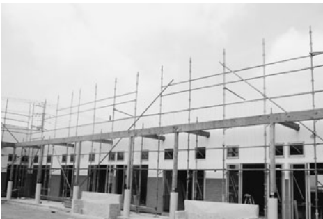
現在建設中の（仮称）ぴよぴよ保育園
